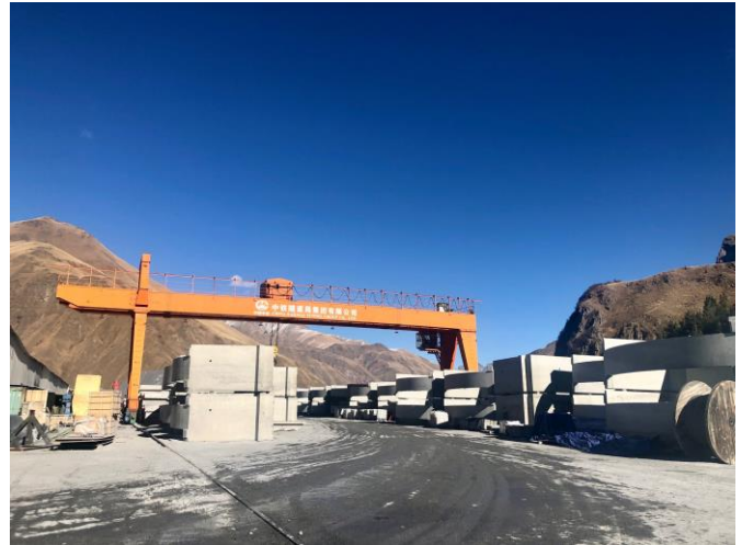
Bau Kobi-Gudauri Tunnel entlang des Nord-Süd-Korridors
